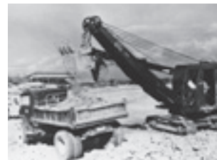
当時の最新土木技術による敷地造成工事
