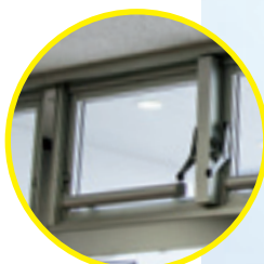
最適な条件となるよう自動的に開く換気窓
